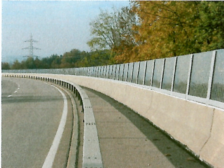
Schutzwände Lorzentobelbrücke, Zug
