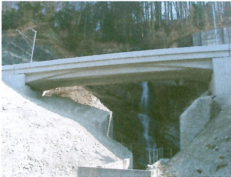
Brücke Grindwäschebach, Walchwil
