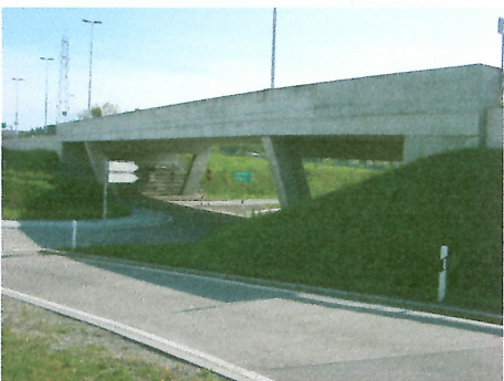
Brücke Anschluss A4, Rotkreuz
